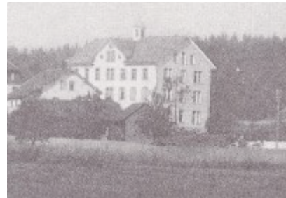
Spritzenhaus an der heutigen Langenthalerstrasse
